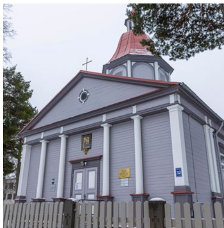
Atjaunota fasāde Majoru Romas katoļu draudzes baznīcai.
