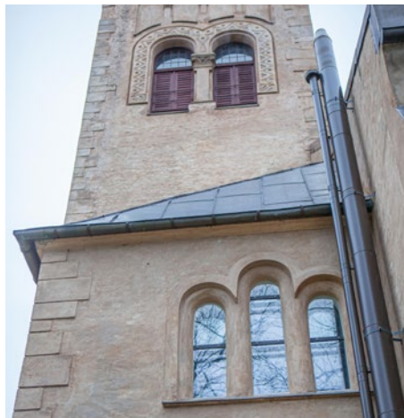
Dubultu evaņģēliski luteriskajai baznīcai ar pašvaldības līdzfinansējumu veikta otrā stāva logu renovācija.
