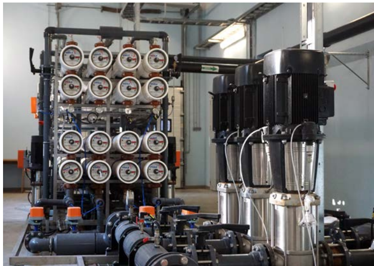
Dzintaros izbūvētās ūdens sagatavošanas stacijas nanoeiārtas nodrošina Eiropas Savienības prasībām atbilstošu ūdens kvalitāti.
