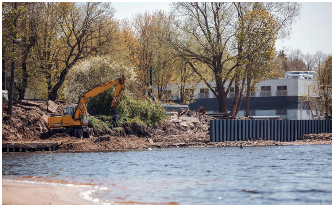
Lielupes krasta nostiprinājuma izbūve norisinās vairākos posmos. Attēlā: preti Teātra ielai tiek veikti nostiprinājuma izbūvei nepieciešamo rievpāju iedzišanas darbi.
